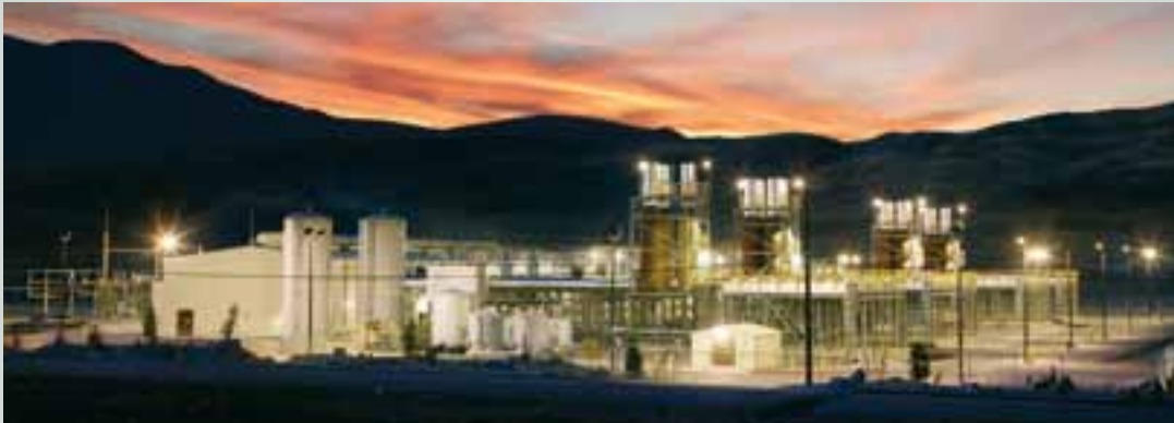
Wärtsilä Power Plantsin voimaloiden kokonaistoimitukseen sisältyy moottoreiden lisäksi paljon muitakin lämmönvaihtimista ja äänenvaimentimista moottorihallien teräsrakenteisiin. Kuvan dieselvoimala sijaitsee Yhdysvalloissa keskellä Nevadaa. KUVA: WÄRTSILÄ
