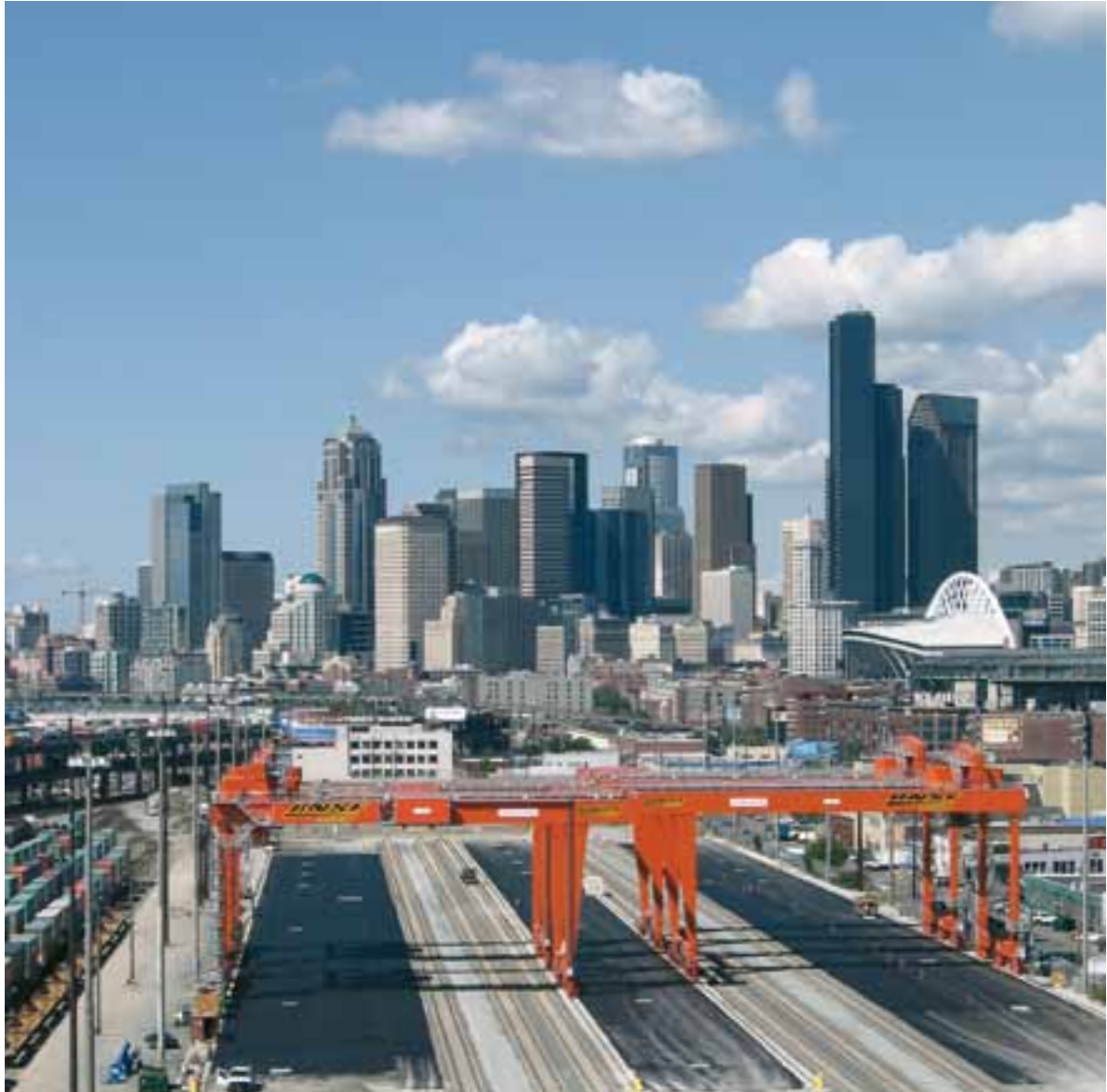
Konecranesin nostureita on toimitettu satamiin eri puolille maailmaa. Kuvassa oleva kiskoilla kulkeva pukkinosturi sijaitsee Seattlessa Yhdysvalloissa. KUVA:KONECRANES
