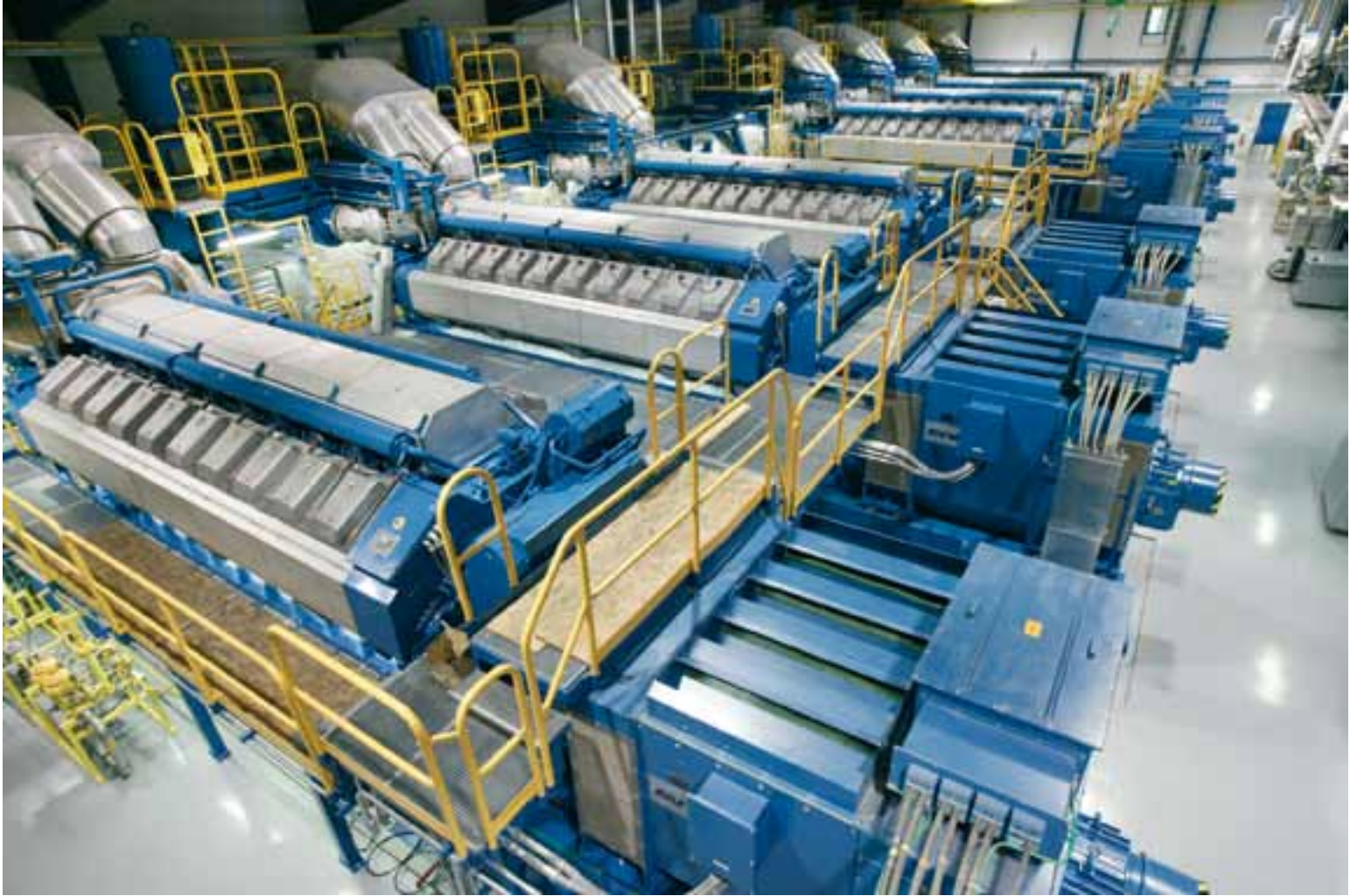
Wärtsilä Power Plantsin toimittamien voimaloiden moottorihalleissa pyörivät yhtiön valmistamat dieselmoottorit. KUVA: WÄRTSILÄ
