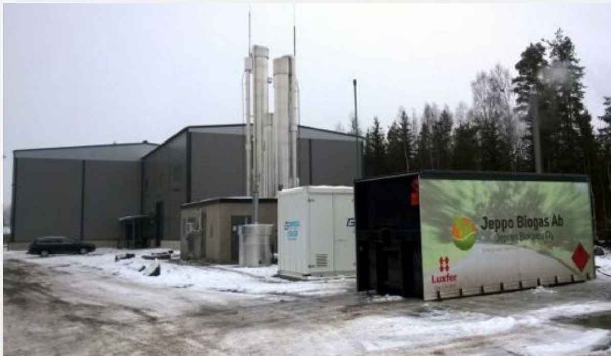
Kuva 9. Jepuan biokaasulaitoksen kaasunjalostus- ja paineistusyksikkö sekä kaasukontti.
