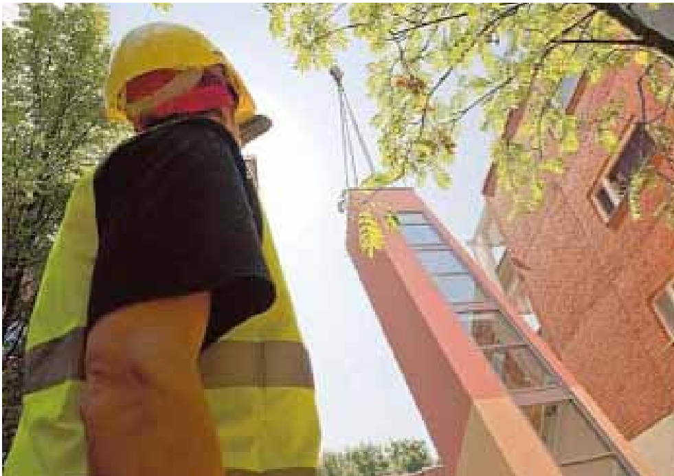
Kuva 10. Esimerkki hissitornielementin asentamisesta rakennuksen julkisivuun.
