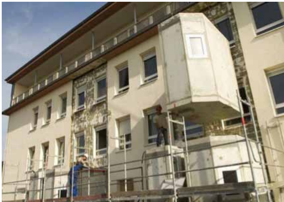
Kuva 9. Esimerkki kylpyhuone-elementin asentamisesta.
