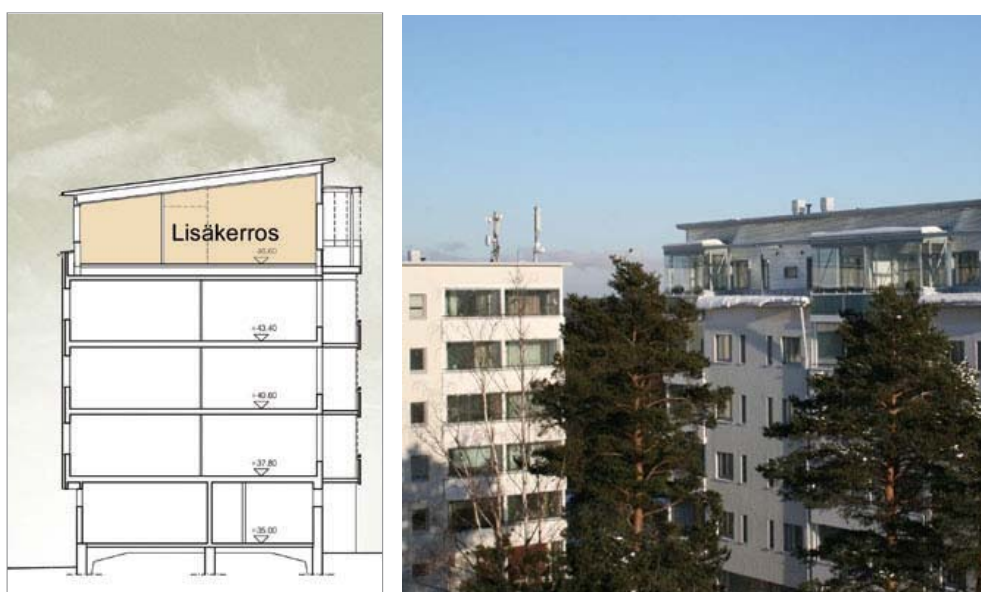
Kuva II. Esimerkki elementtikerrostaloon rakennetusta lisäkerroksesta.
